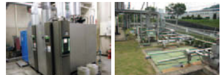
ボイラー 福崎工場の水処理施設
