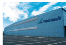
[プラスチック容器成型工場] ファクトリー2(インドネシア) 敷地面積: 54,442㎡
