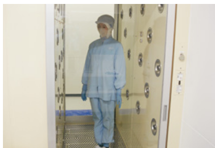
異物混入防止の対策(エアシャワー)
