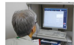
本社ビルのデマンド監視装置
