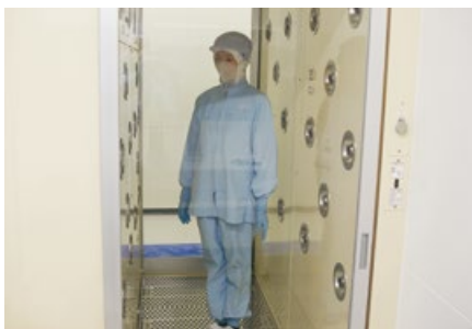
異物混入防止の対策(エアシャワー)
