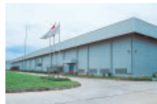
インドネシア (プカシ・チビトン工場)
