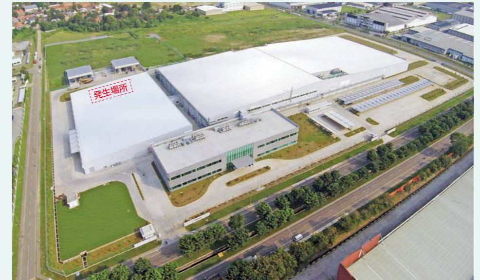
インドネシアの新しい本社社屋と化粧品製造工場(ファクトリー1)の航空写真(2015年2月撮影)
